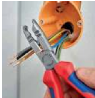
Realizar cortes al acortar conductores individuales
