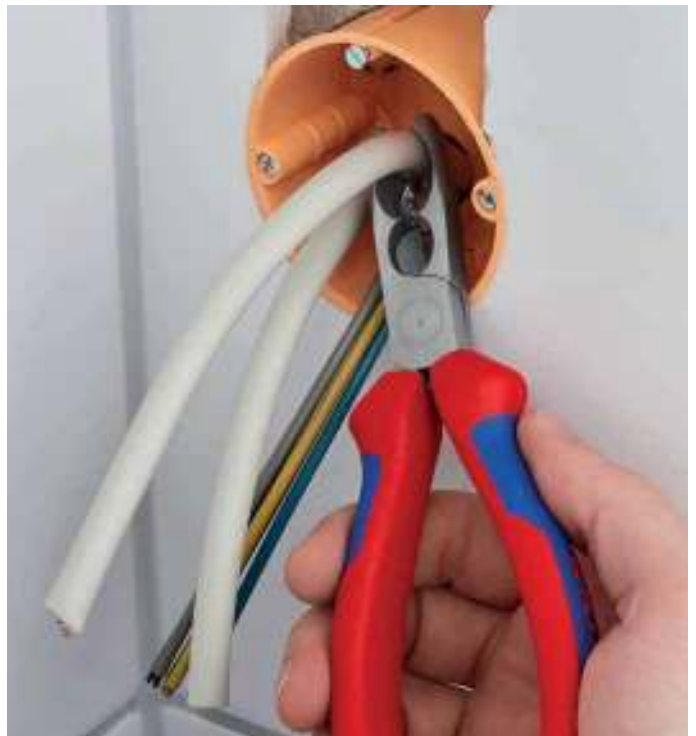
Retirar el aislamiento en la profundidad en cajas empotradas
