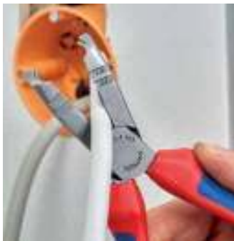
Corta cables con diámetros de hasta 13 mm
