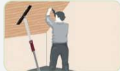
Sujeción y nivelación de trabajos.
