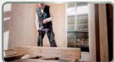
El alto par de giro y las revoluciones constantes producen mucha potencia y resistencia al perforar en madera, incluso con diámetros grandes.
