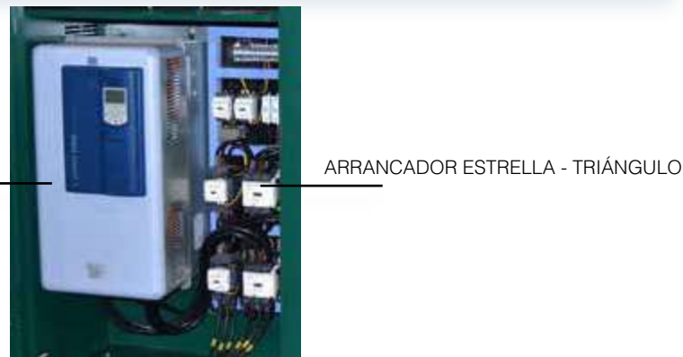
VARIADOR DE VELOCIDAD
